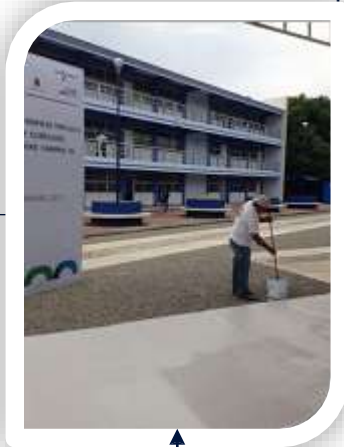
APLICACIÓN DE PINTURA EN FACHADA DEL CAMPUS IV
