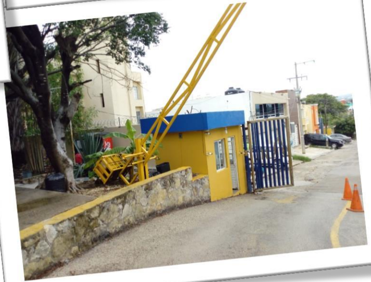
PINTURA EXTERIOR EN CASETAS DE VIGILANCIA
