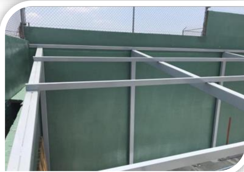
CONSTRUCCION DE TECHUMBRE A BASE DE ESTRUCTURA METÁLICA
