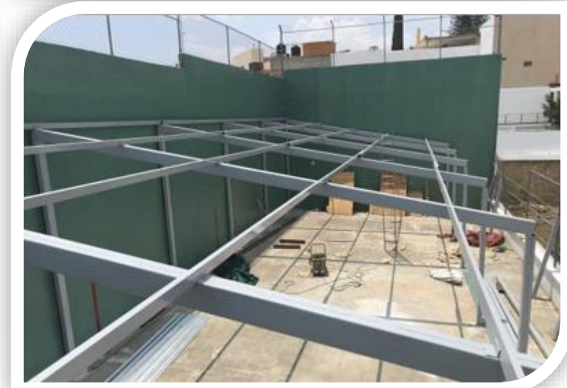
CONSTRUCCION DE TECHUMBRE A BASE DE ESTRUCTURA METÁLICA
