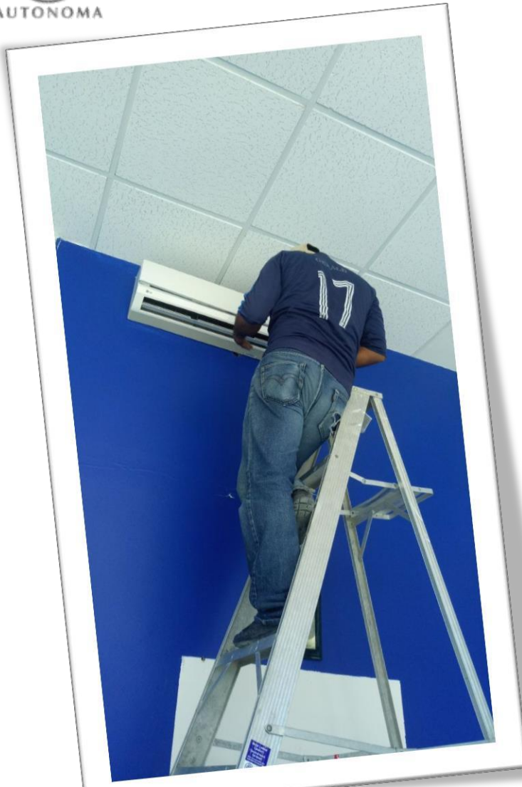
Mantenimiento preventivo de climas en Gym
