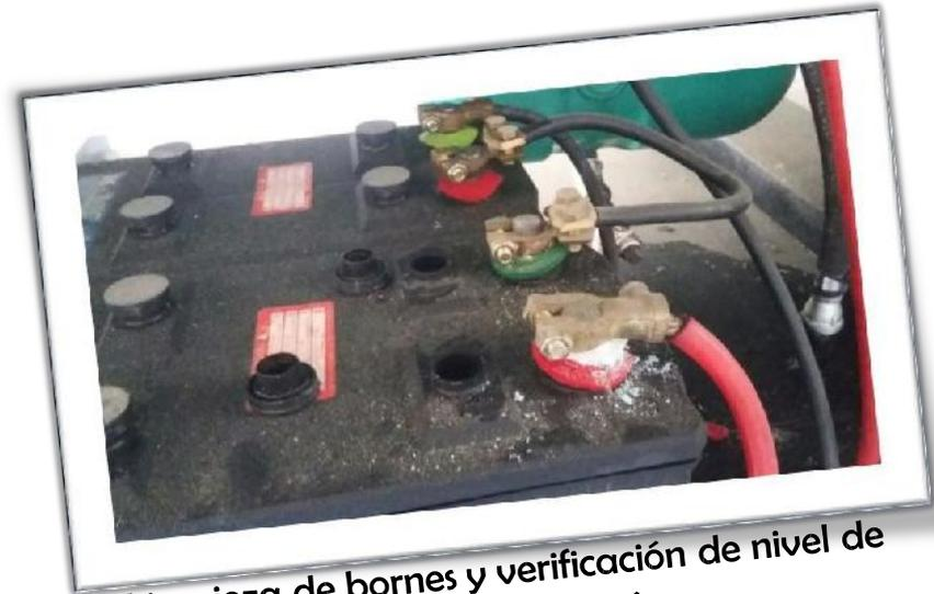
Limpeza de bornes y verificación de nivel de liquido de batería
