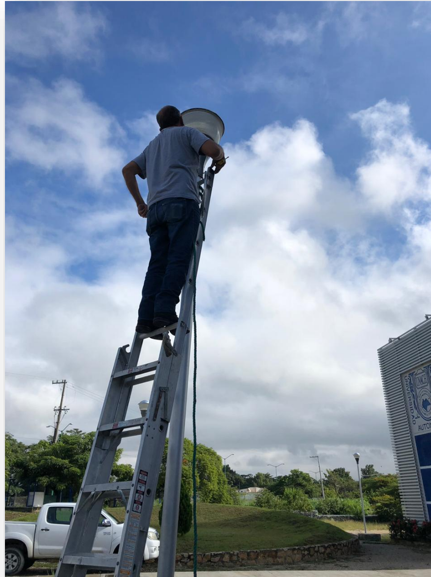
MANTENIMIENTO DE LUMINARIAS EN EXTERIORES
