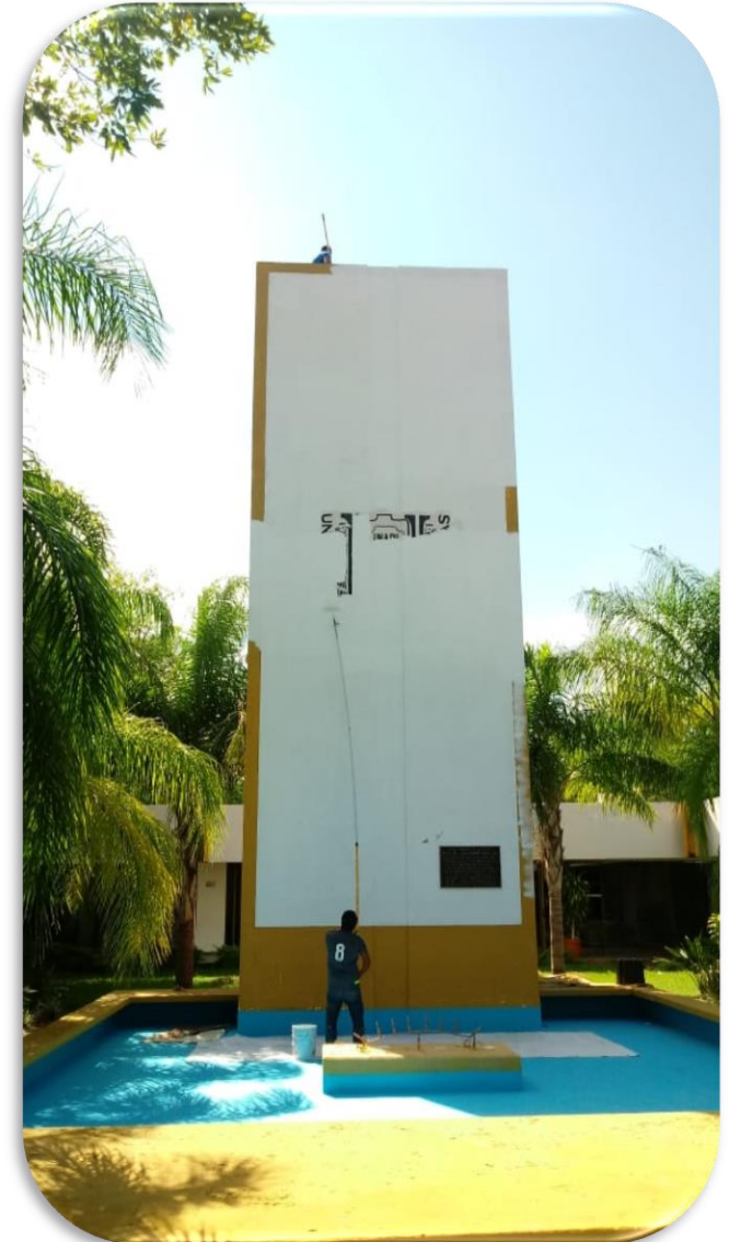
TRABAJO DE PINTURA EN CUBO DE TANQUE ELEVADO DE EDIFICIO DE RECTORÍA
