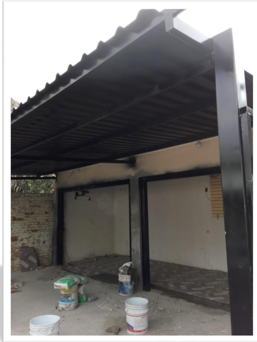
TRABAJO DE HERRERÍA EN ÁREA DE GYM
