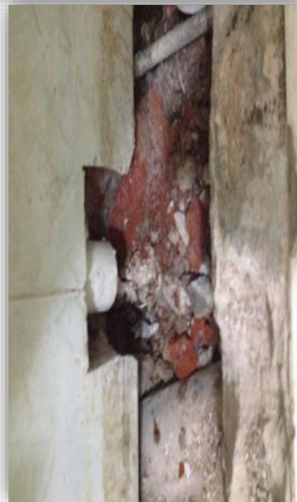
DESAZOLVE DE RED SANITARIA EN MÓDULO DE BAÑOS
