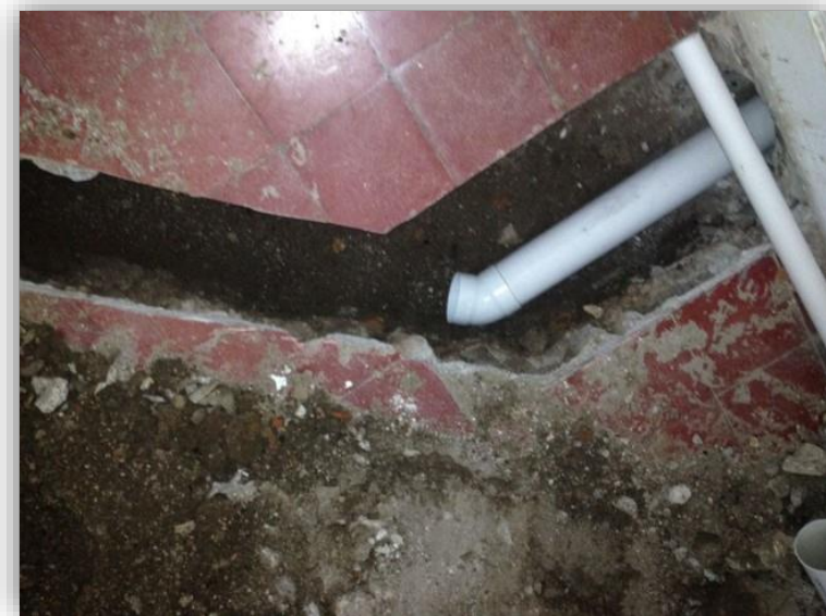
DESAZOLVE DE RED SANITARIA EN MÓDULO DE BAÑOS
